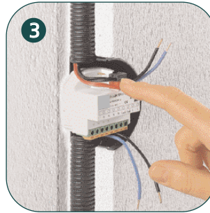
3 Busklemme aufsetzen und über Schwalbenschwanzführung auf Buspins aufsetzen
