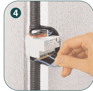
4 Drähte in Federkraftklemmen ohne zusätzliches Werkzeug einsetzen
