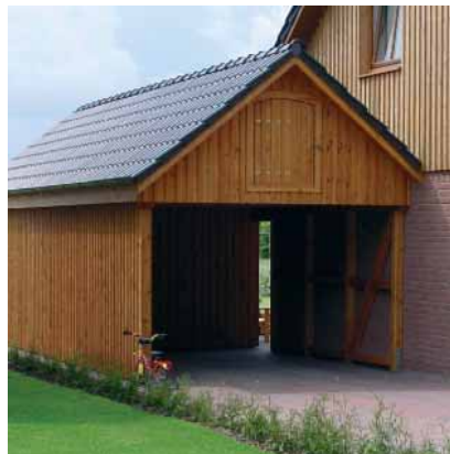
Dank geschickt angeordneter Entwässerung kann auch ein Satteldachcarport direkt ans Haus gestellt werden.
