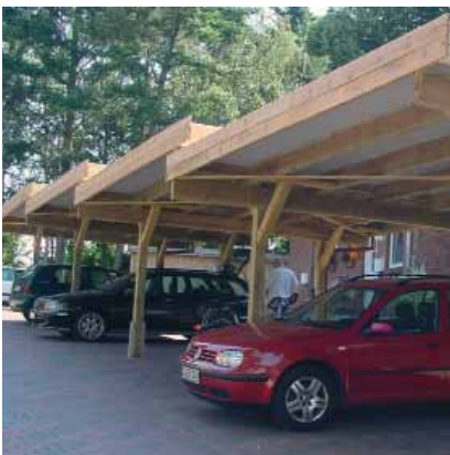
Mit Höhen-Versatz: Die Flachdach- Reihenanlage am Hang schafft viele Stellplätze auf kompaktem Raum.
