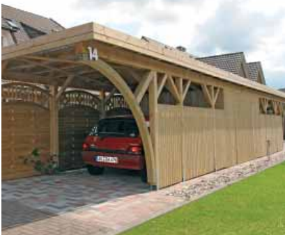
Stellplatzreihe: Doppelcarport, rückseitig zusammengefügt, mit Designelement „Leimholzbogen“ (siehe S. 79)
