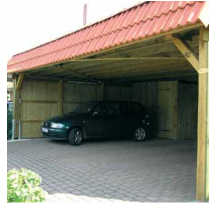
Solider Eindruck: Pfannen (doppelrei- hig) auf der breiten Walmblen- de. Die Wände schließen den Baukörper.
