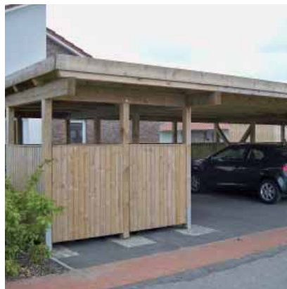
Integrierte Müllplatz-Lösung unter klassischer Stellplatz-Anlage.
