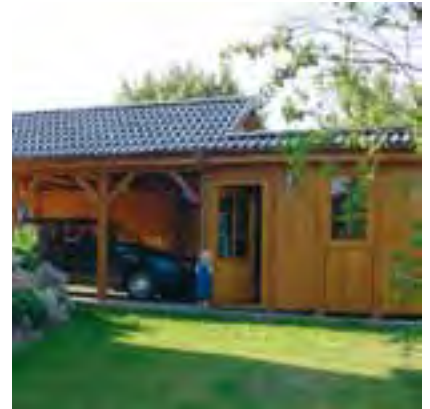
Vorne Satteldach-Carport, hinten Abstellraum mit Flachdach. Joda® baut die individuellen Carports!
