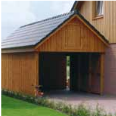
Dank geschickt angeordneter Entwässerung kann auch ein Satteldachcarport direkt ans Haus gestellt werden.
