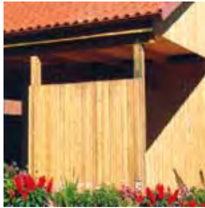
Offener Abschluss mit Durchblick: In das \frac{3}{4} hohe Wandelement kann nachträglich ein Lichtband eingesetzt werden.
