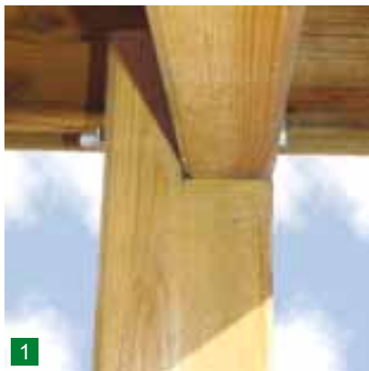
1 Gehobelter Pfosten, bereits ausgeklinkt zur sicheren Aufnahme des Sattelbalkens.
