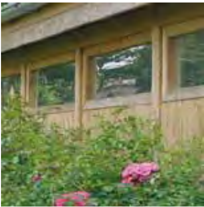
Extra hell mit Lichtband: Joda®Wandelemente mit 435 mm hohen Lichtbändern aus klarem, bruchsicherem PVC.
