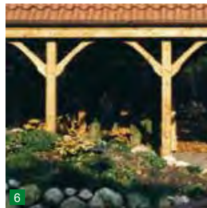
6 Kopfband 90 x 90 mm, geschwungen. Statische Aussteifung, als optische Alternative zu Pos. 5.
