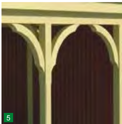
5 Leimholzkopfband 90 x 90 mm, gebogen. Abb.: farbig endbehandelt mit Joda®Color-Allwetterfarbe in Elfenbein
