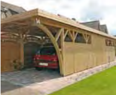
Stellplatzreihe: Doppelcarport, rückseitig zusammengefügt, mit Designelement „Leimholzbogen“ (siehe S. 75)
