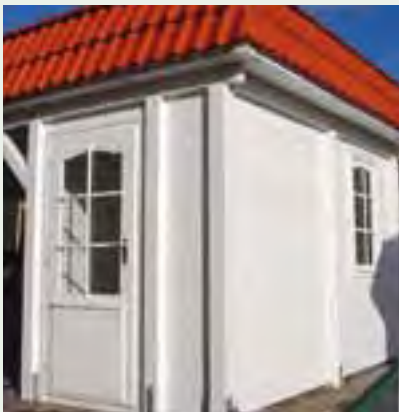
Eingepasst und besonders stark: Räume aus massiv aufeinander gesetzten Blockbohlen.
