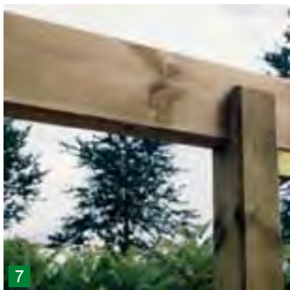
7 Wechsel o. Sattelbalken 60 x 140 mm. Sie bilden zusammen mit den Pfosten das „Grundgerüst“ Ihres Carports.
