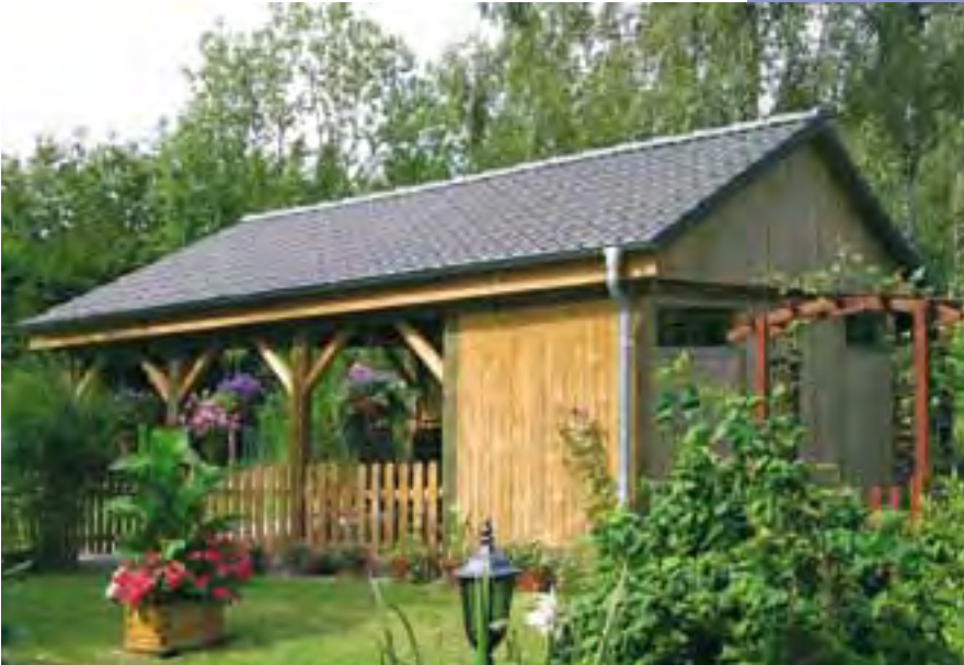
Viel Licht: Der Geräteraum wurde mit einem zweiten Fenster ausgestattet.
