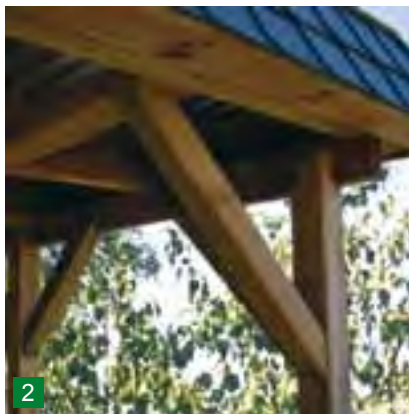
2 Quer-Kopfband für Front- u. Giebelseite zur zusätzlichen Aussteifung und optischen Aufwertung.
