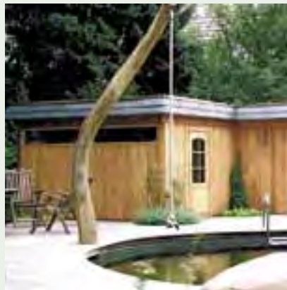
Feine Wirkung dank durchlaufender Blende: Ein rückseitig platzierter Raum ergänzt den Kfz-Stellplatz.
