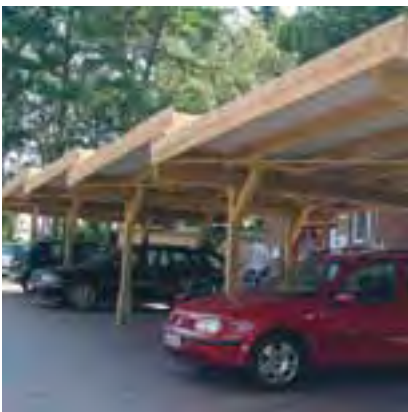
Mit Höhen-Versatz: Die Flachdach- Reihenanlage am Hang schafft viele Stellplätze auf kompaktem Raum.
