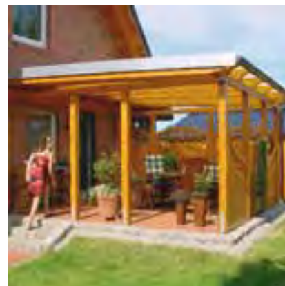
Terrassendach mit Dichtelementen, profilierten Sparrenköpfen und Kupferabdeckung.
