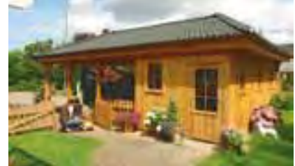
Raum mit Sondertür und -fenster.
