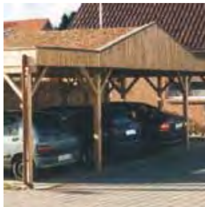
Ein kombiniertes Sattel-/Flachdach ergibt den architektonischen Akzent. Hier eine Variante mit begrümtm Dach.
