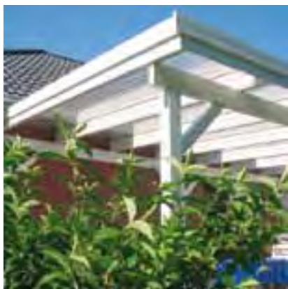
Gut zu sehen: die umlaufender Dachblende bei einem Terrassendach, bauseits weiß farbbehandelt.
