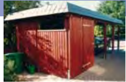
Geräteraum Typ 06 in einem Carport „Glinde“ (Holz wurde bauseits lasiert).
