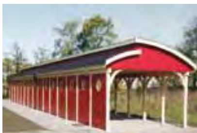
Das XXL-„Capri“ ist auf der Wetterseite mit Wandelementen geschlossen.
