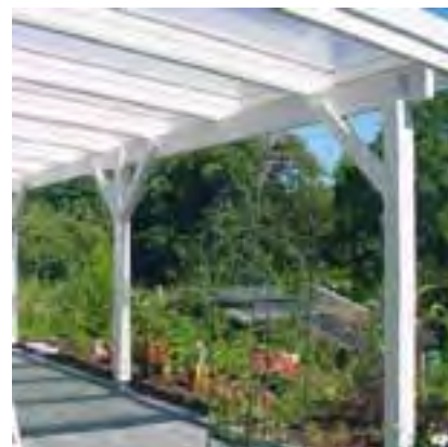
Terrassendach mit umlaufender Dachblende, siehe auch nächstes Bild.
