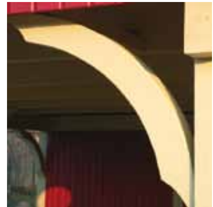
Leimholz-Kopfbänder als elegante Variante (Standard: gerades Kopfband).
