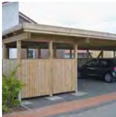
Integrierte Müllplatz-Lösung unter klassischer Stellplatz-Anlage.
