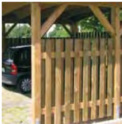
Solide Riegel-Staketten-Konstruktion nach Maß: beidseitig beplankte Wandelemente betonen die Vertikale.
