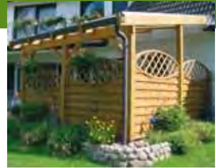
Erweitert Ihr Haus: Terrassendach (Sonderanfertigung) mit Steg-Dreifachplatten, Seiten mit Dichtzaunelementen geschlossen.
