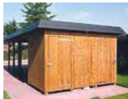
Ergänzung möglich: Geräteraum mit zweiter Tür.
