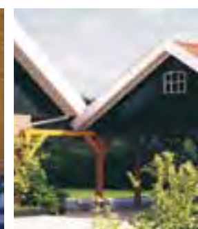
Carport mit „Satteldach“
