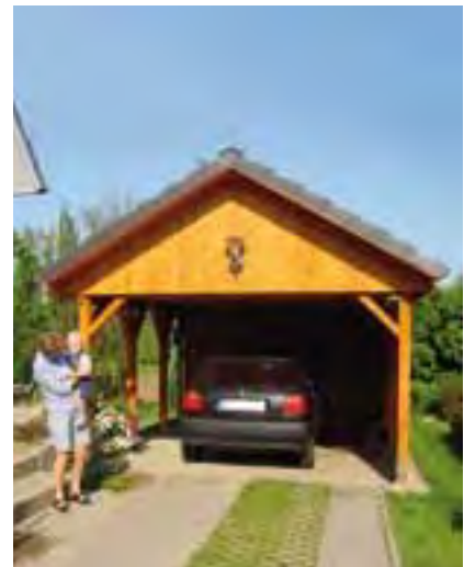
„Meldorf KD“ mit Abstellraum und Wand.
