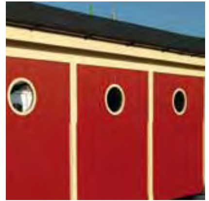
Mit Bullaugen-Fenster oder ganz geschlossen: Die fertigen Joda®Wände (1-seitig beplankt) schließen das Carport.
