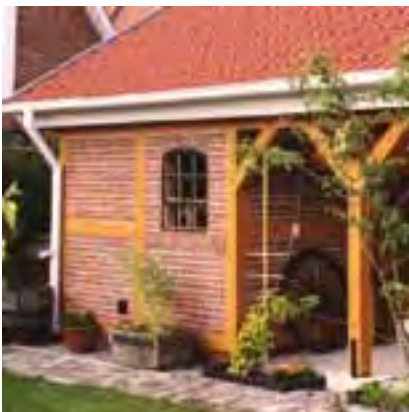
Wände wie anno dazumal? Das Ständerwerk von Joda® kann nach eigenem Gusto bauseits ausgemauert werden.
