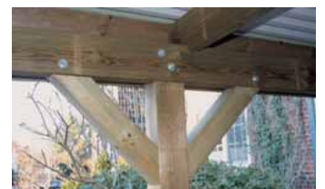
Massive Holzdimensionen, verbunden mit sturmfestem 2-Bolzen-System
