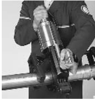
Bild 16: Anbringen der Press-Schlinge
