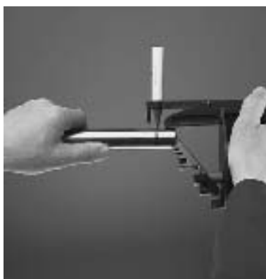
Bild 10: Markieren der Einschubtiefe auf dem Systemrohr
