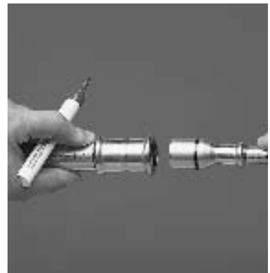
Bild 12: Pressfitting mit Einschubende und Markierung der Einschubtiefe [z. B. Redu-Stück]
