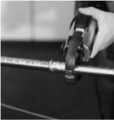
Bild 15: Verpressen mit dem elektro-mechanischen Presswerkzeug
