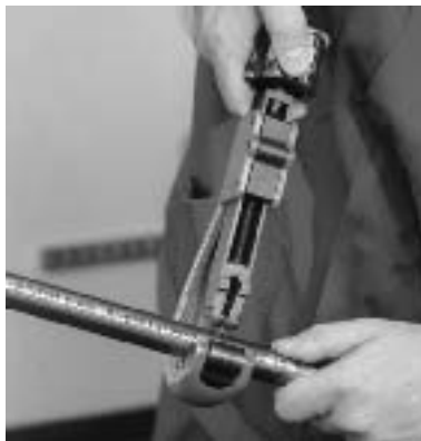
Bild 8: Ablängen des Systemrohrs mit dem Rohrschneider
